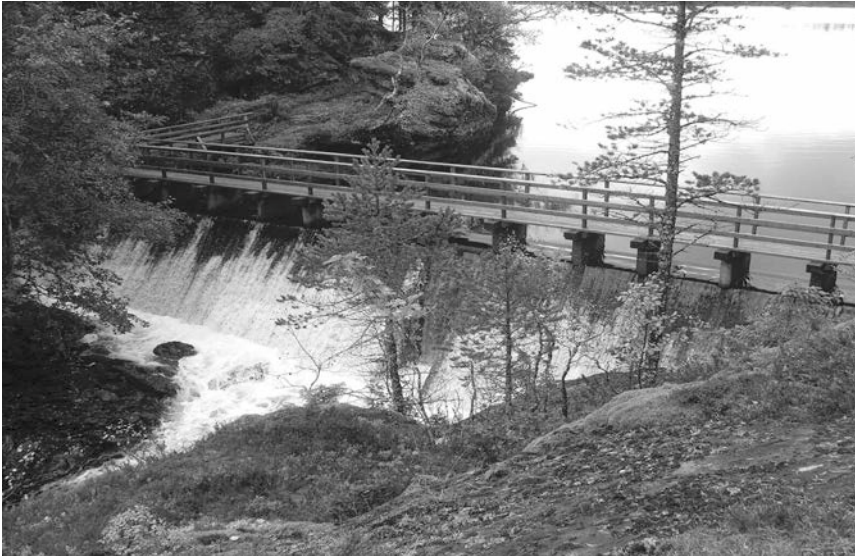
Grønningsdammen ferdig rehabilitert.
