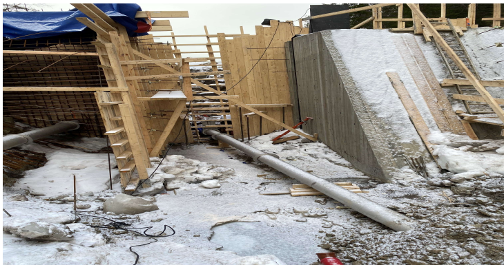
Gåssjødammen under oppføring.
