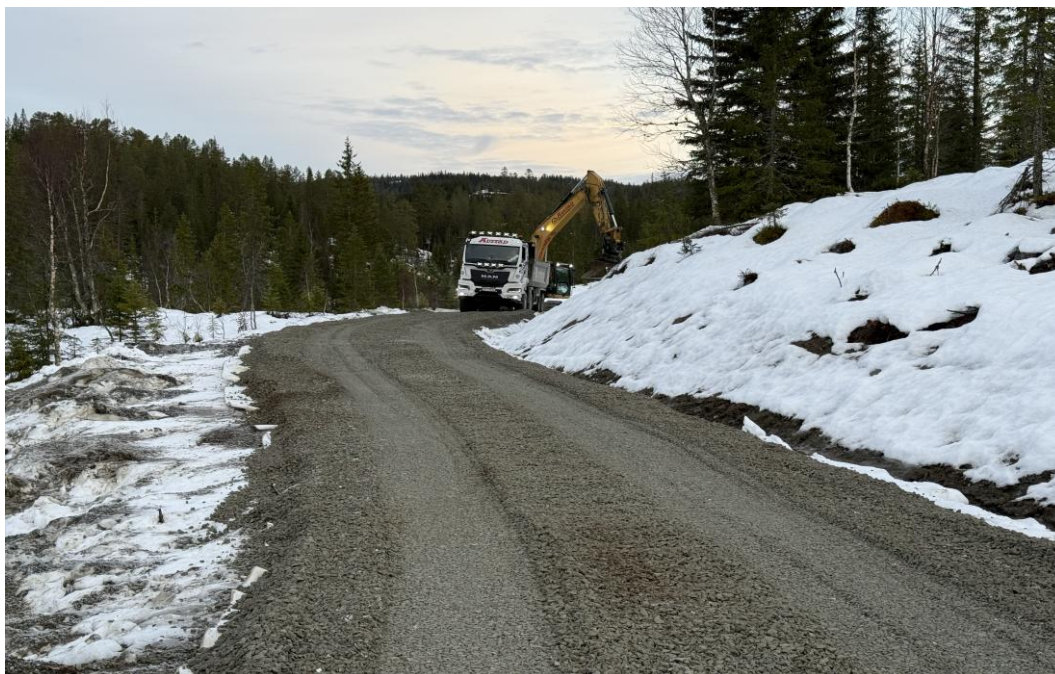
Veg opprusting Grønningsvegen
