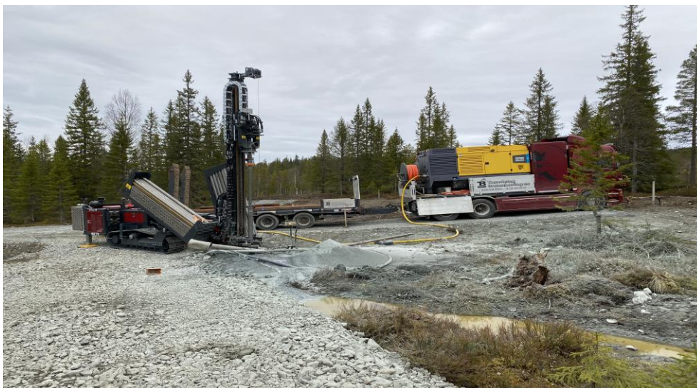
Grunn vannboring til vannforsyning i Finnåsen hyttefelt.
