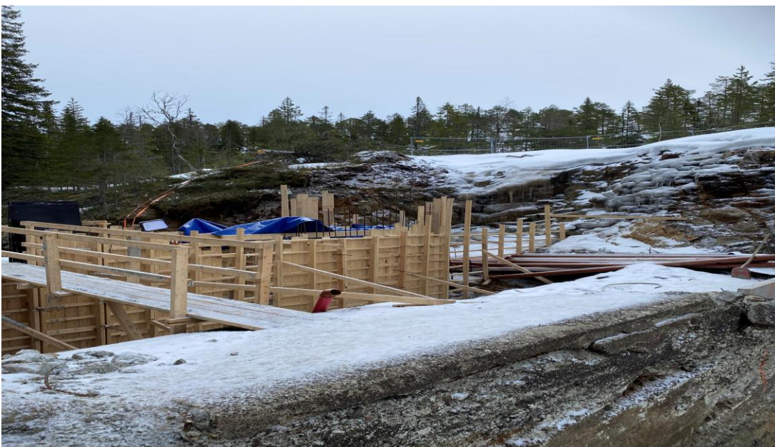
Gåssjødammen under oppføring.
